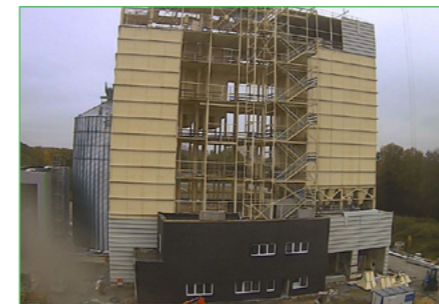
Ein Blick durch die Webcam auf die Baustelle.
