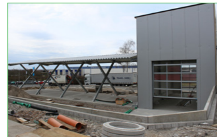
Noch ist das zukünftige Waschzentrum eine Baustelle.
