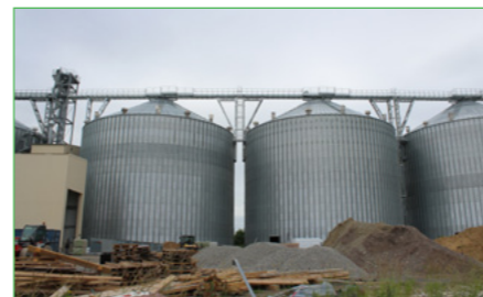
Die neuen Silos in Geseke werden in Kürze fertiggestellt sein.
