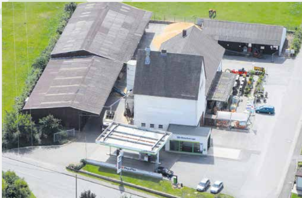
Am Standort Lichtenau-Henglar betreibt die RWM den Agrar- und Einzelhandel sowie die Tankstelle.
