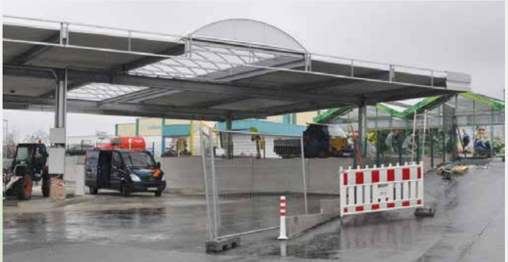
Die neue SB-Tankstelle liegt direkt neben dem Raiffeisen-Markt im Gewerbegebiet an der Randebrockstraße.
