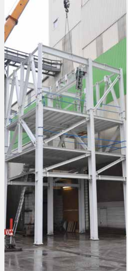
Aktuell werden 16 neue Rohwarenzellen für Komponenten am Standort in Büren gebaut.
