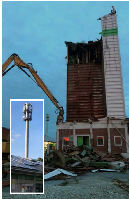
Großes Gerät war im Einsatz: Der markante Siloturm in Soest wurde jetzt abgerissen.
